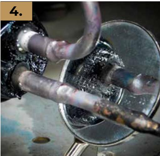
Verificar que no exista falta de soldadura en cada una de las uniones realizadas en el filtro deshidratador.
