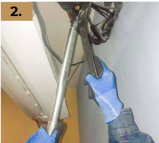
Se conectan los tubos que fueron abocinados en los tubos del evaporador. Después se ajustan las tuercas. Nota: los tubos que se conecten deben de responder a las medidas de los tubos provenientes del evaporador
