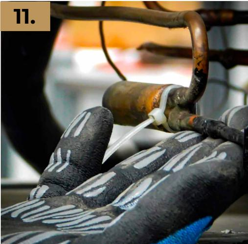
Se verificará que no existan residuos de aceite sobre las uniones de los tubos del compresor, de igual modo se buscan fugas con una solución jabonosa. Si se llegaran a encontrar dichos residuos o burbujas, las fugas y/o fracturas deberán ser reparadas para poder realizar el cambio del compresor aplicando el procedimiento de reparación
