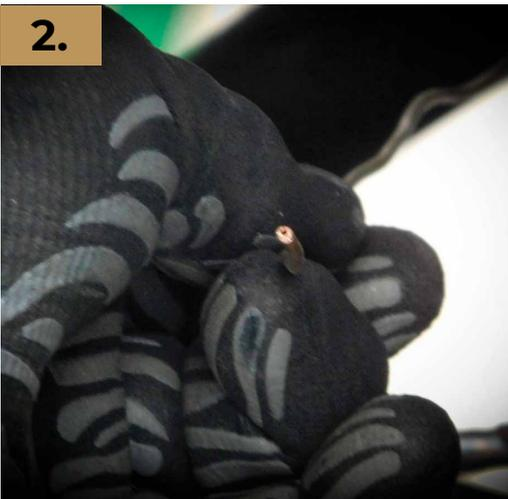
Verificar que no exista obstrucción en la punta del tubo capilar
