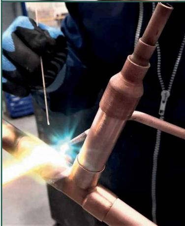
El procedimiento para estas uniones es básicamente idéntico al utilizado para la soldadura fuerte de cobre con cobre, con la única diferencia de que inicialmente se debe concentrar más calor en el accesorio para alcanzar la temperatura necesaria. Tener cuidado de no sobrecalentar el accesorio. Bastará con un color rojo apagado. Utilizar varillas de soldadura fuerte con mayor contenido de plata (Ag).
