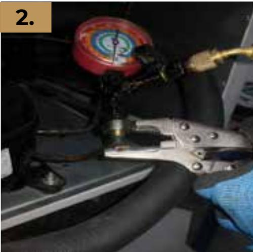
Colocar la manguera venteo de 8 mm de diámetro y de una longitud de 8 m en conexión de la pinza punzante a la válvula de líquido del tanque recuperador.
