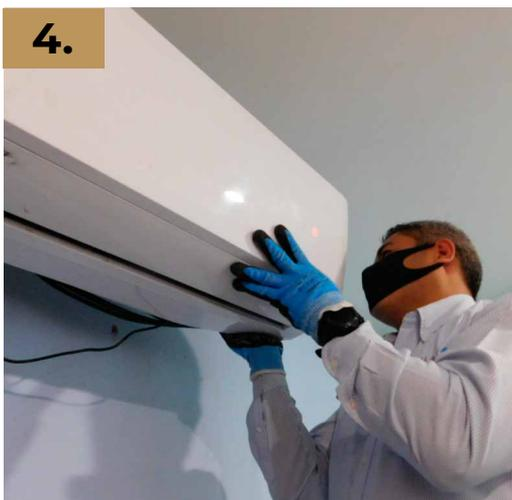
Una vez que la base de la unidad evaporadora se encuentra totalmente sujeta, las tuberías y el cable de señal conectado, se procede a insertar la unidad evaporadora. Nota: para introducir la unidad evaporadora, es necesario primero introducir tubería y cableado en la perforación realizada
