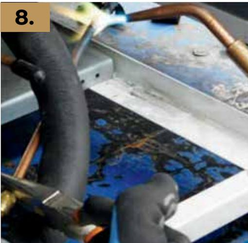
Colocar la válvula de servicio al tubo de servicio del compresor
