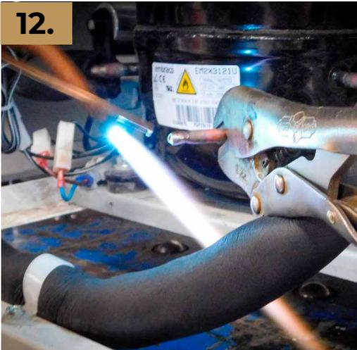
Una vez retiradas las válvulas de conexión rápida, se procede a sellar los tubos de servicio del compresor y del filtro deshidratador
