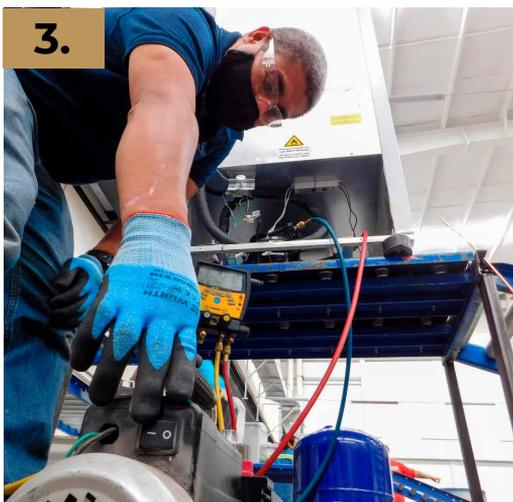
La bomba de vacío deberá encender con el gas ballast abierto. Al hacerlo se evita que se acumule humedad en el interior de la bomba, lo que previene daños ocasionados por la humedad que podría ser aspirada.
