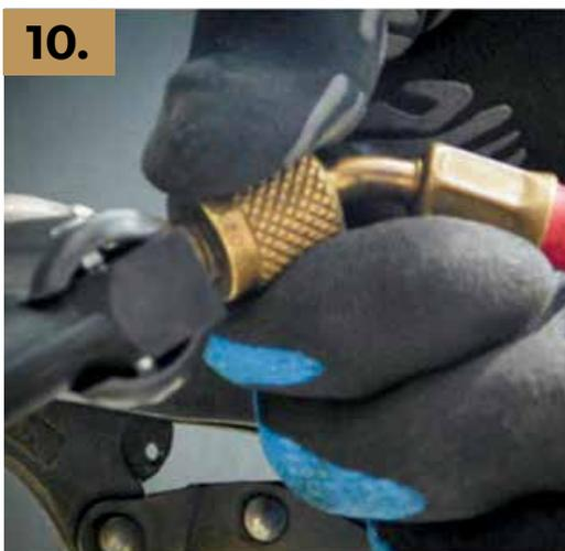
Retirar las mangueras del manómetro colocadas en las válvulas de servicio del compresor y del filtro deshidratador
