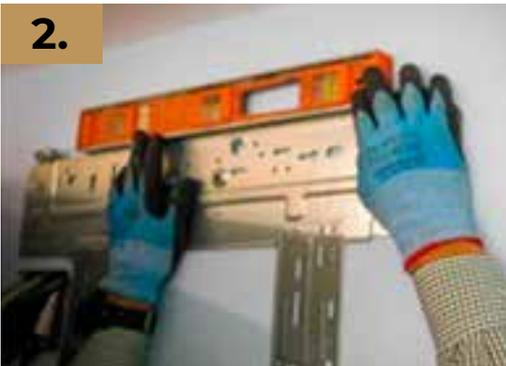
Una vez identificado los 25 cm, se toma la base de evaporador para llevar a cabo su nivelación sobre la superficie donde se ubicará
