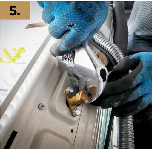
Se conecta el tubo de alta proveniente de la unidad evaporadora a la salida de alta de la unidad condensadora.
