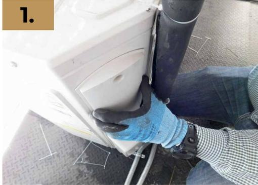
Se retira tapa protectora de válvulas de la unidad condensadora para llevar a cabo la conexión de tubería
